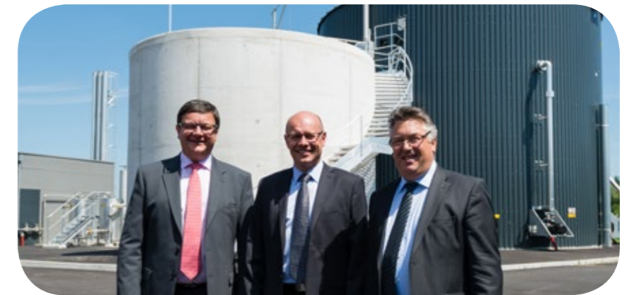
Station d'épuration et de méthanisation des boues de la Basse-Zorn
