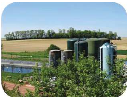
Station de traitement des lixiviats
